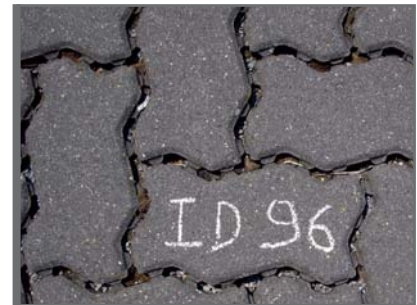
Figuur 3.40 Betonstraatstenen met verbrede voegen
