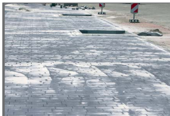
Figuur 3.27 Klassieke voegvulling van ongebonden materiaal
