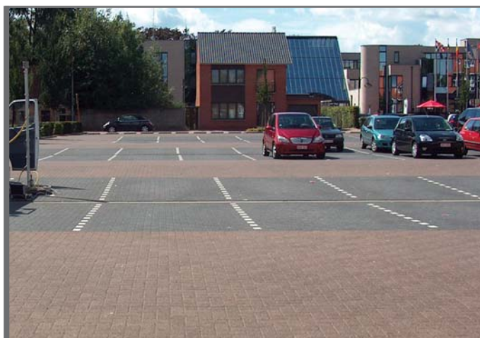
Figuur 1.3 Waterdoorlatende bestrating op een parkeerterrein
