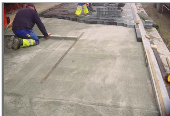
Figuur 3.23 Aanbrenging van de straatlaag
