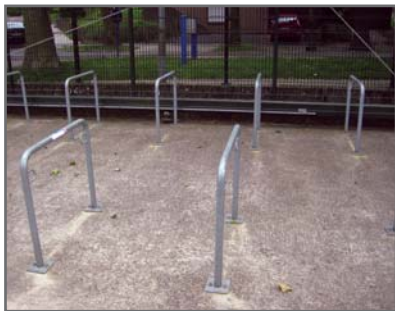
Figuur 3.8 Halfopen verharding onder straatmeubilair vermijden en/of afstemming van het meubilair op toekomstig onderhoud (verwijderbare obstakels, zwevend meubilair)
