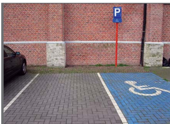
Figuur 3.19 Voorbeeld van onvoldoende afstemming op toekomstig (alternatief) onkruidbeheer: probleemzone tussen de parkeerplaatsen en de muur die weinig gebruikt (betreden) wordt en wegens de vele obstakels (fietsstalling, elektriciteitskasten, verkeersbordpalen) moeilijk machinaal te onderhouden is
