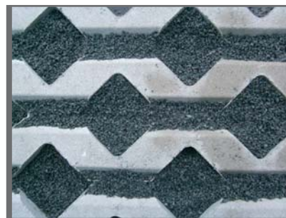
Figuur 3.43 Grasbetontegels met steenslagvulling
