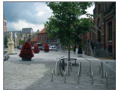
Figuur 3.8 Halfopen verharding onder straatmeubilair vermijden en/of afstemming van het meubilair op toekomstig onderhoud (verwijderbare obstakels, zwevend meubilair)
