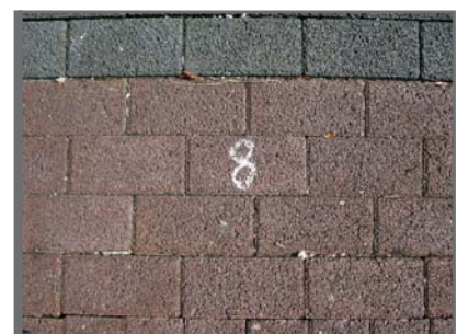
Figuur 3.42 Poreuze betonstraatstenen
