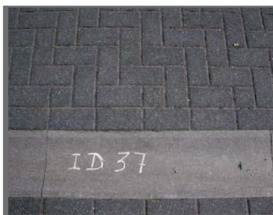
Figuur 3.14 Geprefabriceerde betonnen gootbanden en/of geschikte, waterdichte voegvulling om onkruidgroei tegen te gaan
